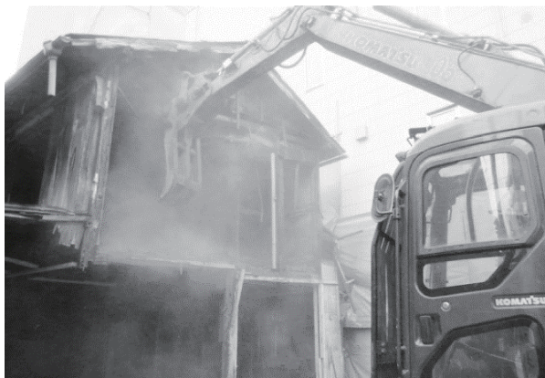
散水をせず粉塵をまきちらしての解体
