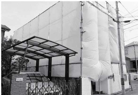
隙間なく丁寧に張られた養生シート
