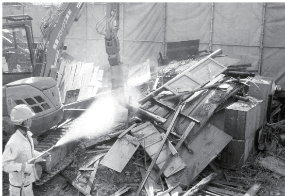
十分な水量での散水作業
